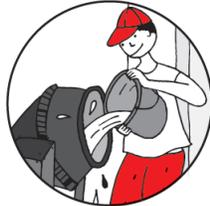
Verser la moitié de l'eau nécessaire (5 l) dans la bétonnière ou auge à mortier.
